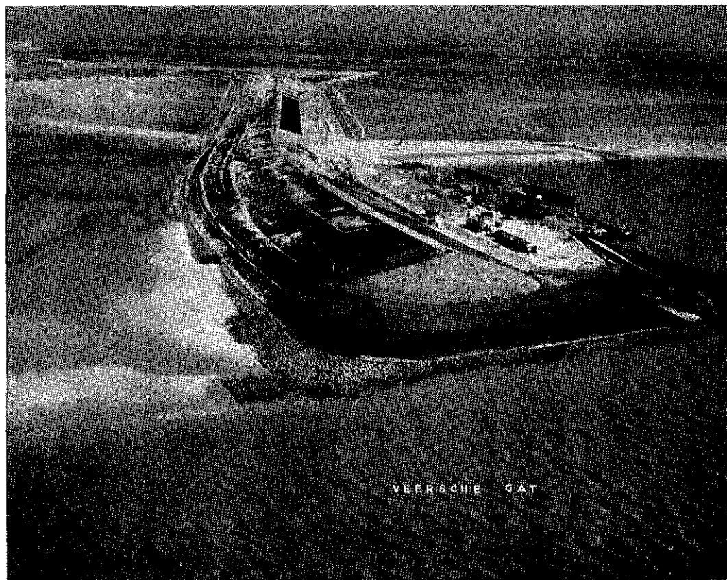
Overzicht van het werk op 3 oktober 1958. De oppervlaktebehandeling met gebroken grind is op de kop zichtbaar.
